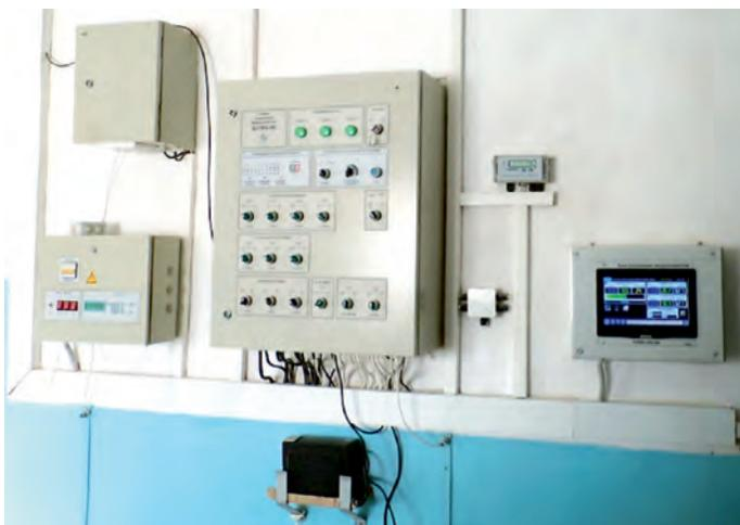
Рис. 3.19. Общий вид системы управления микроклиматом «Климат 2.0» от компании «Микроэл»
