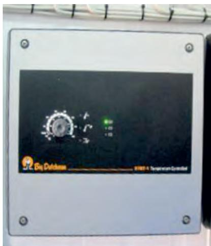
*Рис. 3.23. Блок аварийного открытия приточных элементов*
