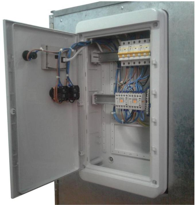
Рисунок 13 – Общий вид электрического щита монтажного
