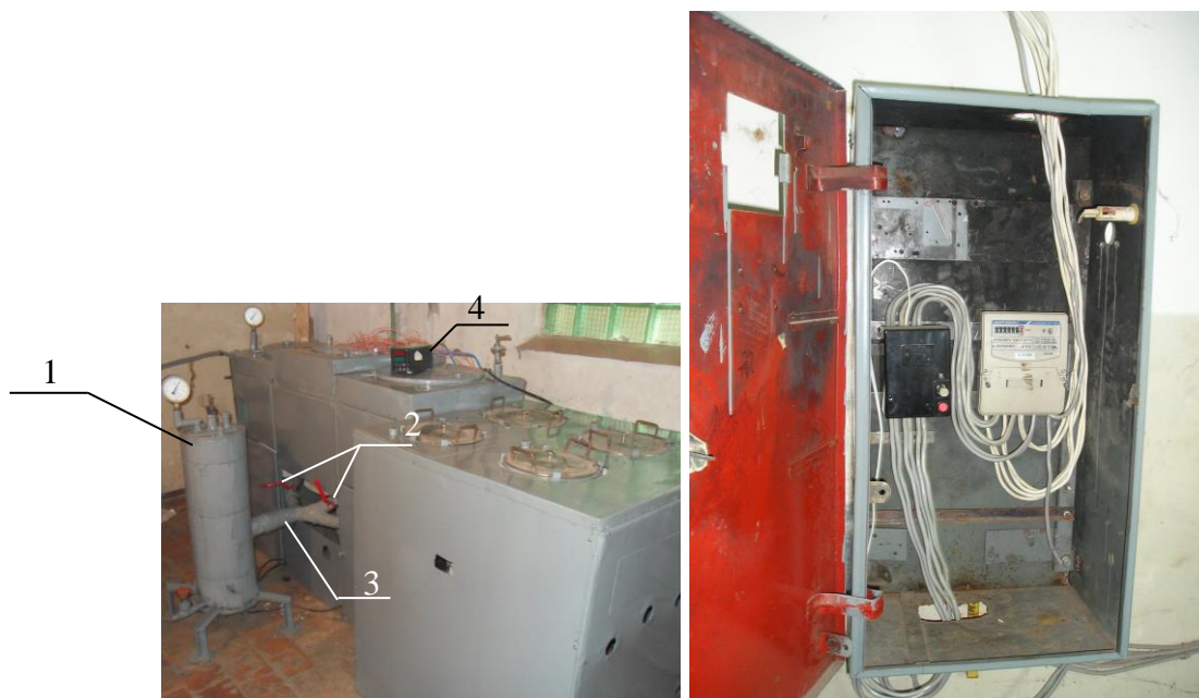
1 – электропарогенератор; 2 – запорная арматура, 3 – пароконденсатопровод; 4 – измеритель температур УКТ 38.
