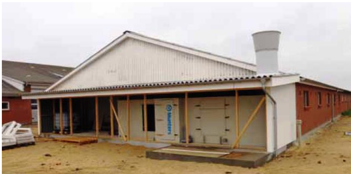
Рис. 5. Горизонтальный воздухоочиститель от Munters A/S.
