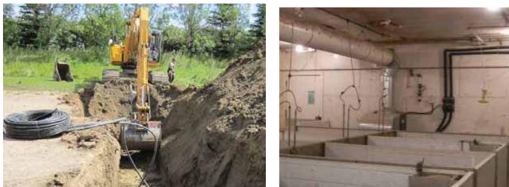
Рисунок 2. Монтаж труб для наземного источника отопительной системы, установленной в свинарнике.
