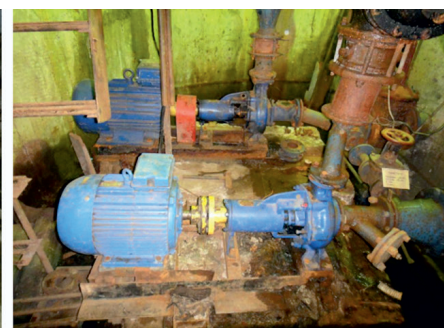
Рис. 1. Внешний вид насосов в колодцах малых населенных пунктов
